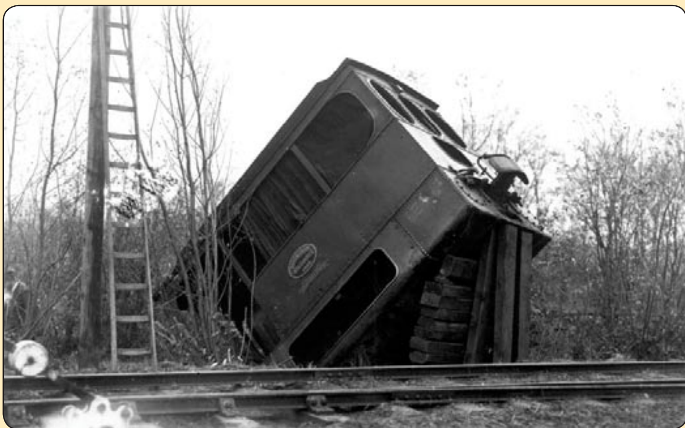
Op 4 november 1934 belandde de tram in een sloot door een stuurfout in een bocht op de Abeelse Zandweg. Er deden zich geen persoonlijke ongeukken voor. Om het wegzakken te voorkomen werd de tram gestut met spoorbielzen.
